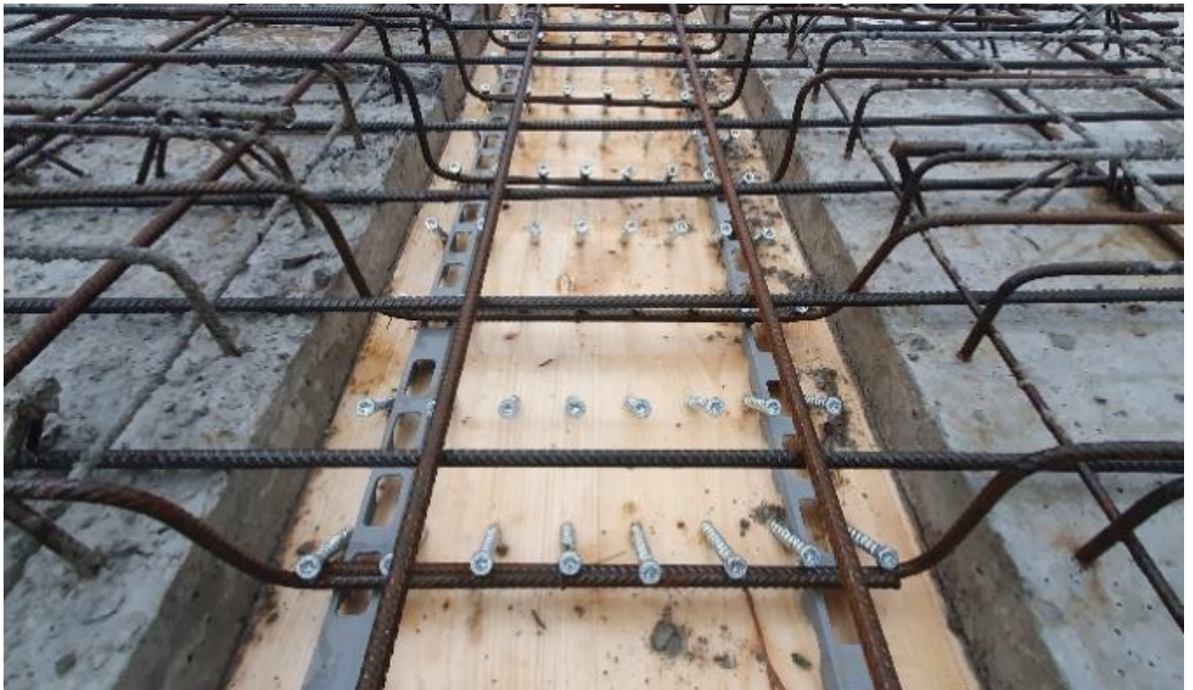
Abb. 10: Binder, Halbfertigteile, Verbundschrauben und Bewehrung vor der Betonage der Decke
