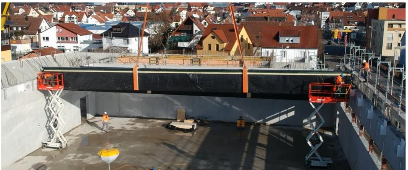
Abb. 17: Montage der Leimholzträger mit dem Autokran
