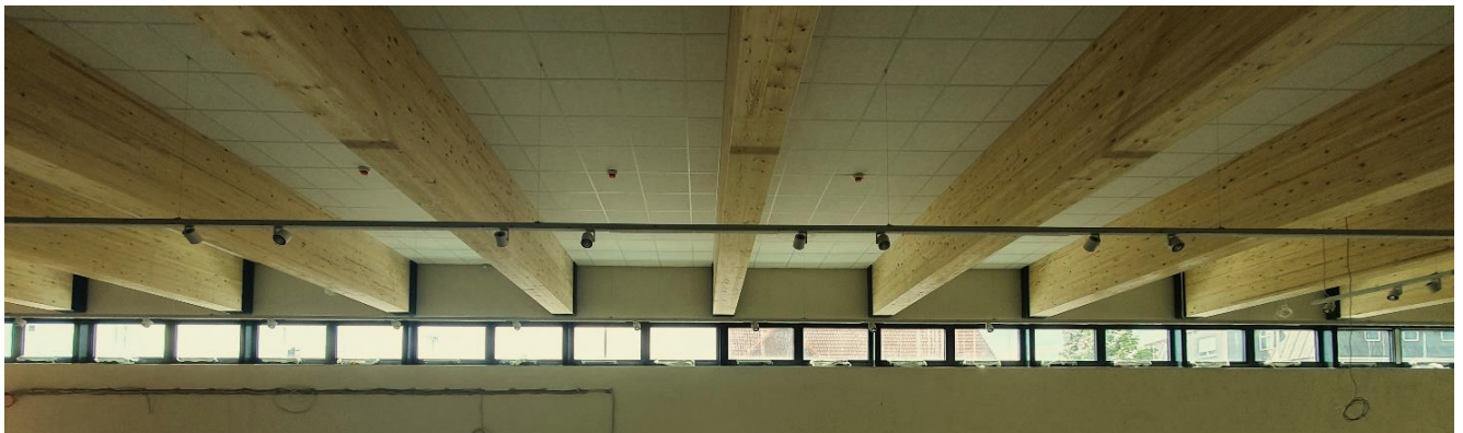
Abb. 22: Untersicht der fertiggestellten Holz-Beton-Verbunddecke und der Außenwand mit Lichtband
