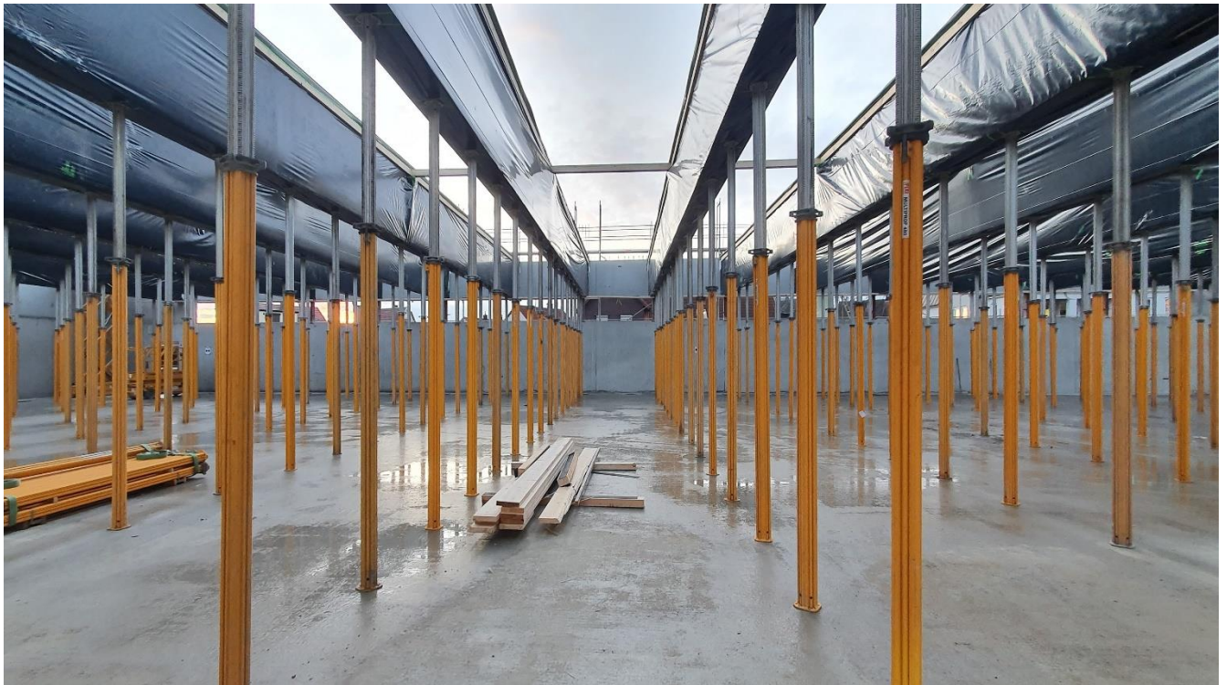
Abb. 9: Unterstützte Binder im Bauzustand
