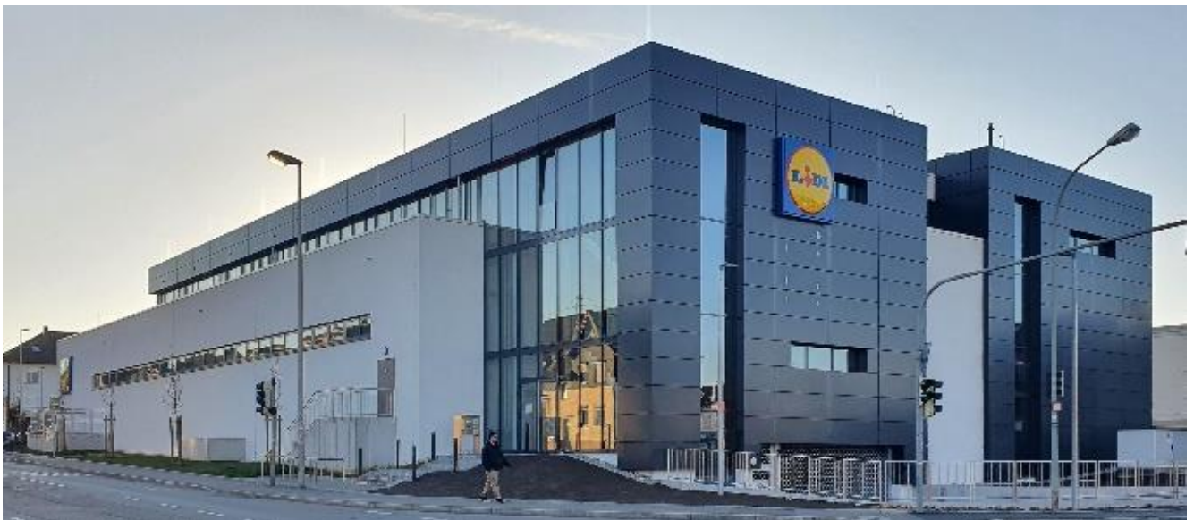
Abb. 3: Ostansicht des Gebäudes
