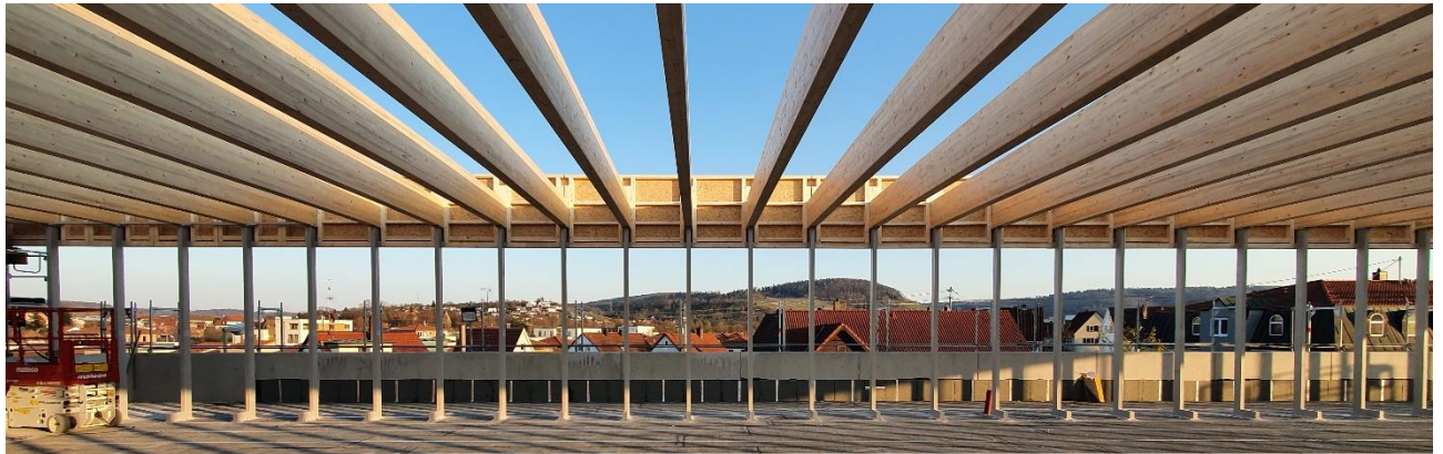
Abb. 20: Stahlständer – Holzträger – Konstruktion im OG für das Bürogeschoss auf der HBV-Decke. Kippstabilisierung der Holzträger durch die Holzscheibe für die Attika
